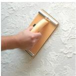
После полного высыхания поверхность шлифуется для удаления «гребешков», «задиров», неровностей. Шлифовку предпочтительнее производить шлифовальной теркой (размер зерна 20-30). Возможную пыль удалить щеткой.
