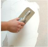
Нанесение первого слоя. Покрытие наносится кельмой равномерным слоем на толщину наполнителя.
