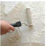
Нанесение лака. Для создания основного тона необходимо нанести заколерованный акриловый лак «Оптимист» с помощью мехового валика. Во избежание образования стыков лак наносится на всю обрабатываемую поверхность сразу, от угла до угла. Необходимо дать поверхности полностью просохнуть.
